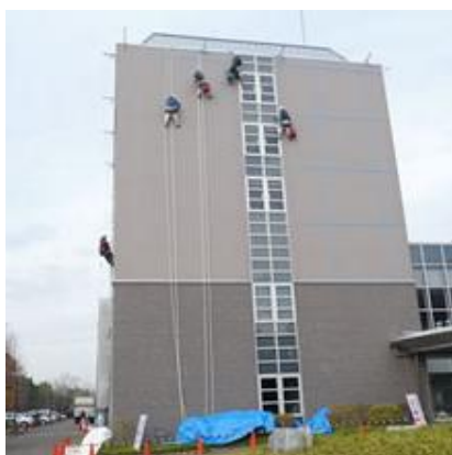
写真4. ブランコ足場/外装専科 webより
